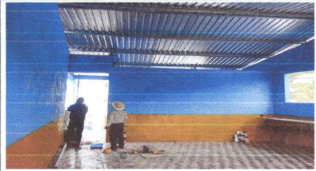
Foto 2: Instalacion de puertas de metal de aula y dirección de la escuela.
