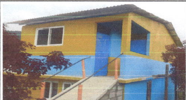
Foto 4: Se observa como quedaron instaladas las puertas y ventanas la escuela por medio del remozamiento ejecutado.
