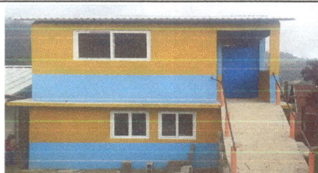
Foto 3: En la presente fotografia se observa como quedo la pintura exterior del aula y dirección.
